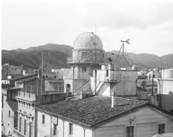
FIGURA 1. Imatge de l'Observatori Català a Sant Feliu de Guíxols. Centra la imatge la cúpula astronòmica, però és possible observar-hi alguns dels elements que formaven l'estació meteorològica. Just al peu de la cúpula, al costat dret, hi ha l'abric per a termòmetres i altres instruments, el penell i el mesurador de l'anemòmetre Richard i, més a la dreta, el penell i el mesurador de l'anemòmetre Bourdon. Còpia de l'original, sign. SMC-350-C, dipositat a la Cartoteca de Catalunya. © Institut Cartogràfic i Geològic de Catalunya.
